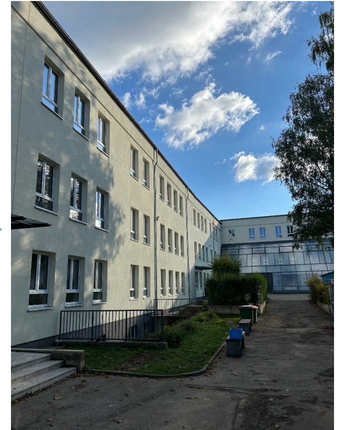
Fassade nach Fertigstellung
