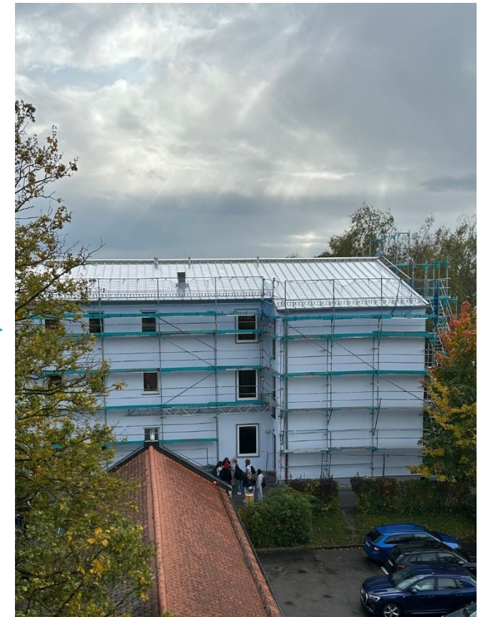
Fassade und Dach nach Fertigstellung
