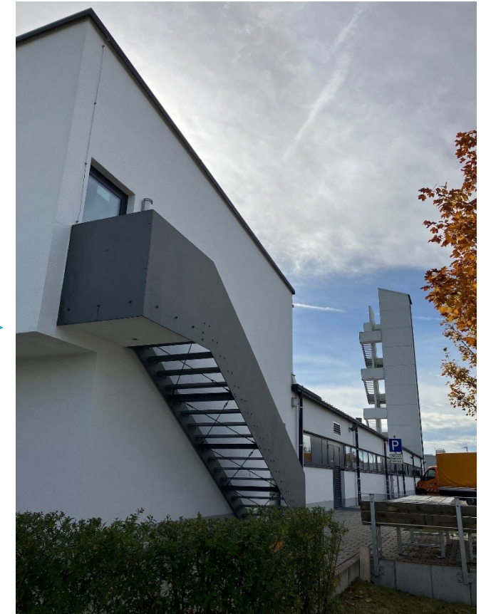
Fassade nach Fertigstellung
