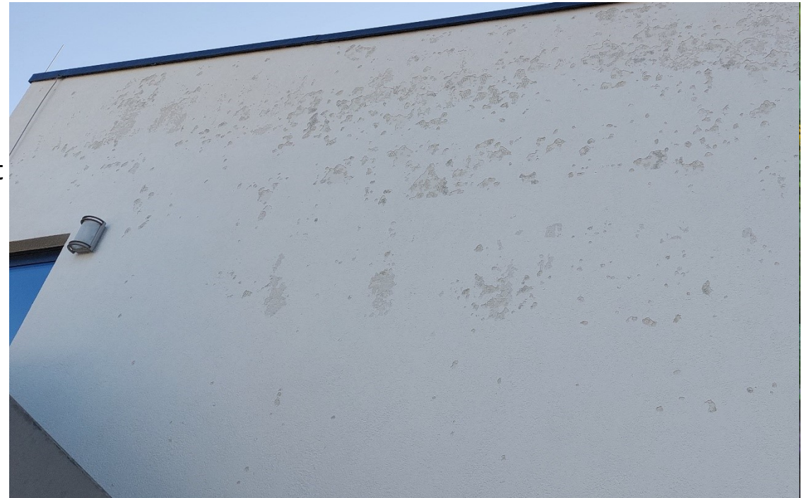
Beispielbild: Fassade Feuerwehr Bobingen
