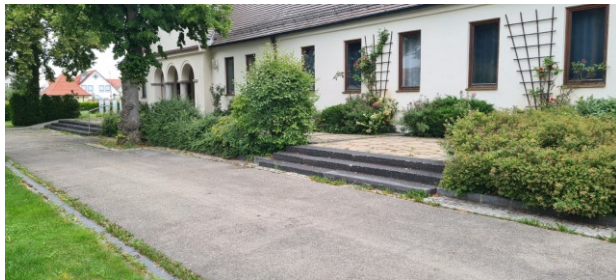
Bestehender Zustand Blick auf die Aussegnungshalle
