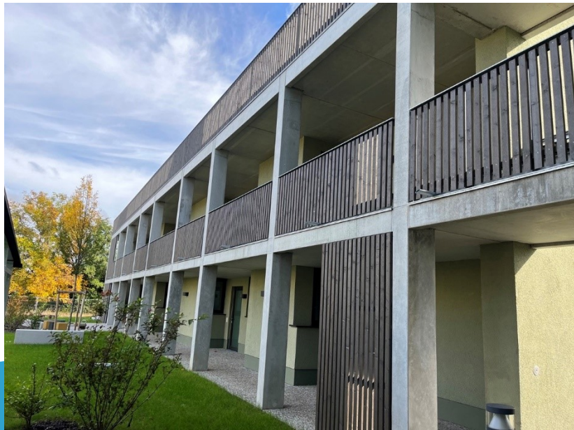
Laubengang als Eingangssituation
