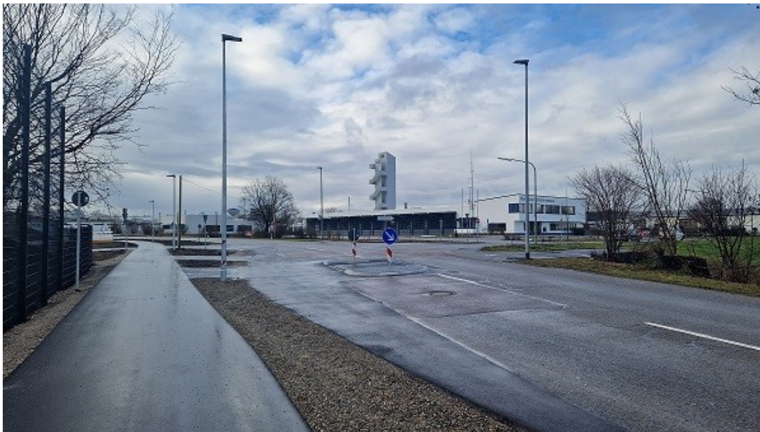
Bildunterschrift: Zwei neue Querungshilfen verringern die Unfallgefahr und erleichtern dem Fuß- und Radverkehr das Überqueren der Fahrbahn Bildnachweis: Eva-Maria Gürpinar
